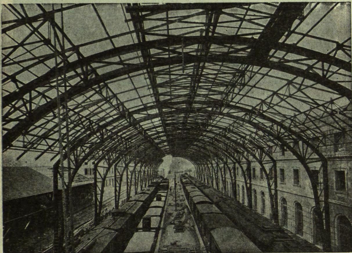
Estación internacional de Port-Bou.—Cubierta de andenes.—Agosto-Diciembre 1928.
